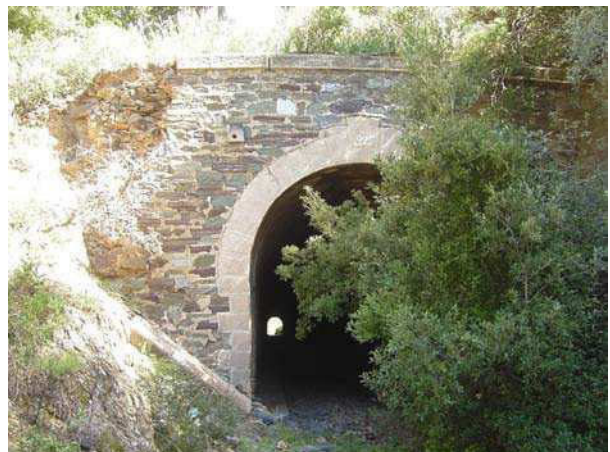
Ingresso della galleria con data di costruzione
