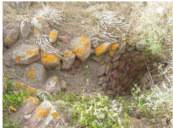
Particolare camera torre laterale
