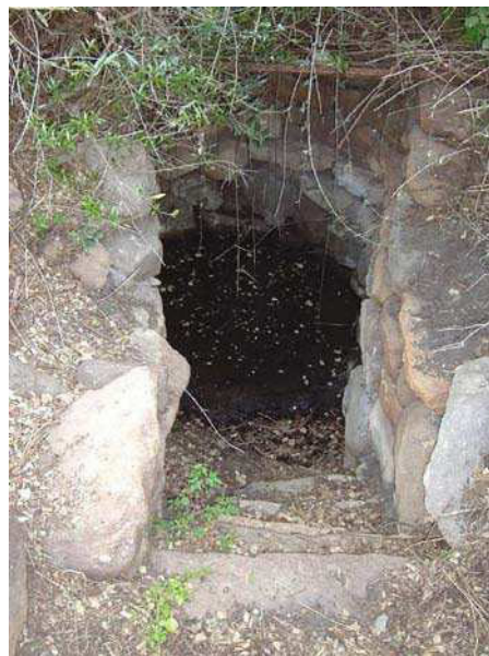
Particolare della camera del pozzo
