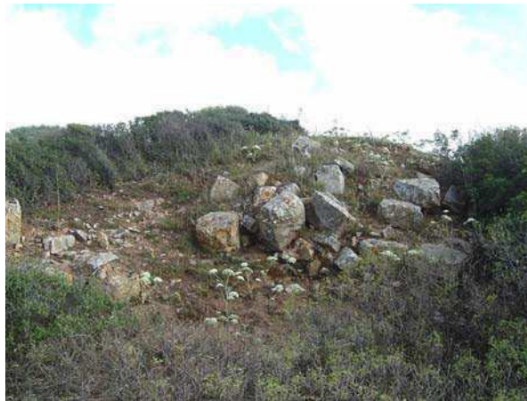
Particolare del crollo del nuraghe
