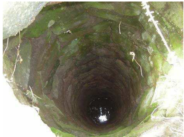
Interno del pozzo
