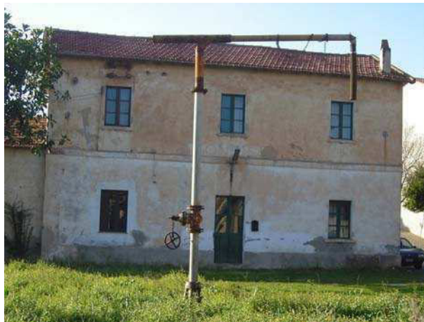
Prospetto della stazione ferroviaria
