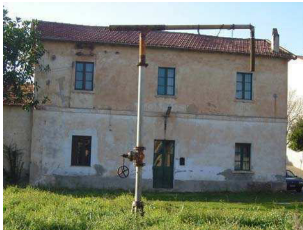
Prospetto della stazione ferroviaria
