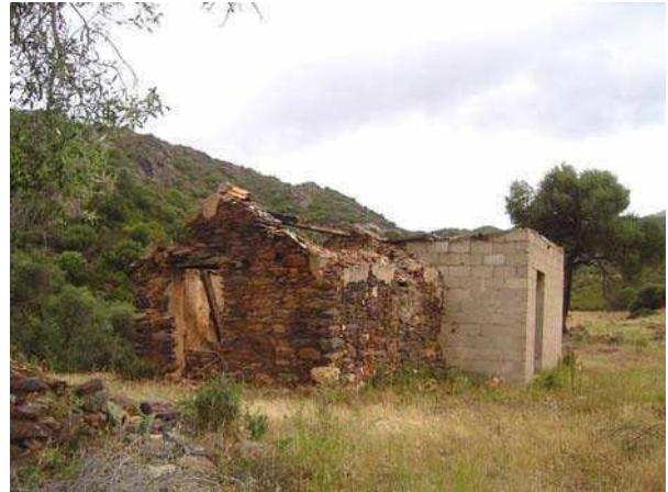
Particolare di un edificio in lastre di scisto con ampliamento in blocchetti
