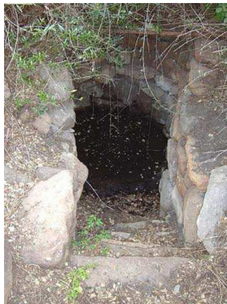
Particolare della camera del pozzo
