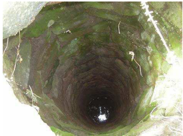
Interno del pozzo
