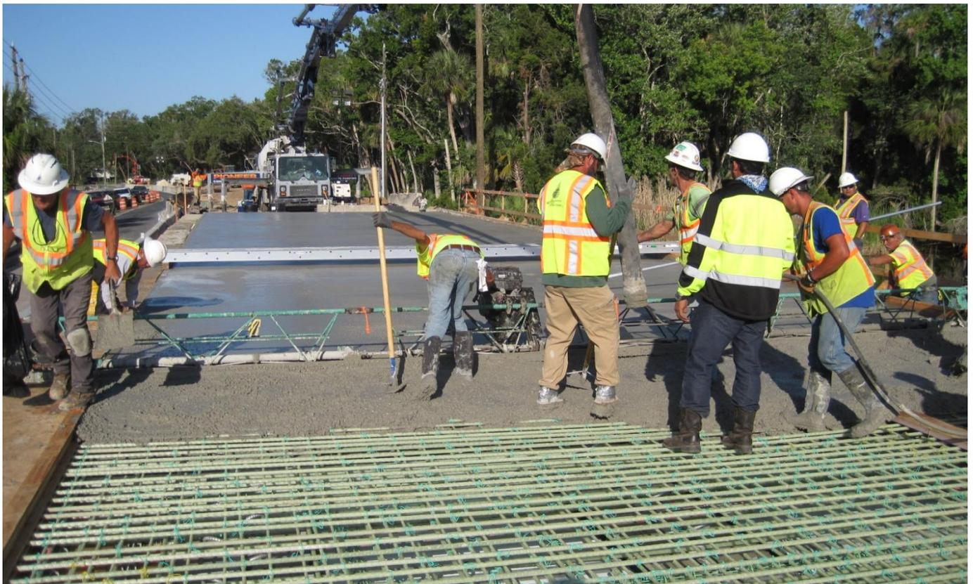
*Figura 3 - Esempio di realizzazione di una soletta da ponte con armatura in GFRP*
